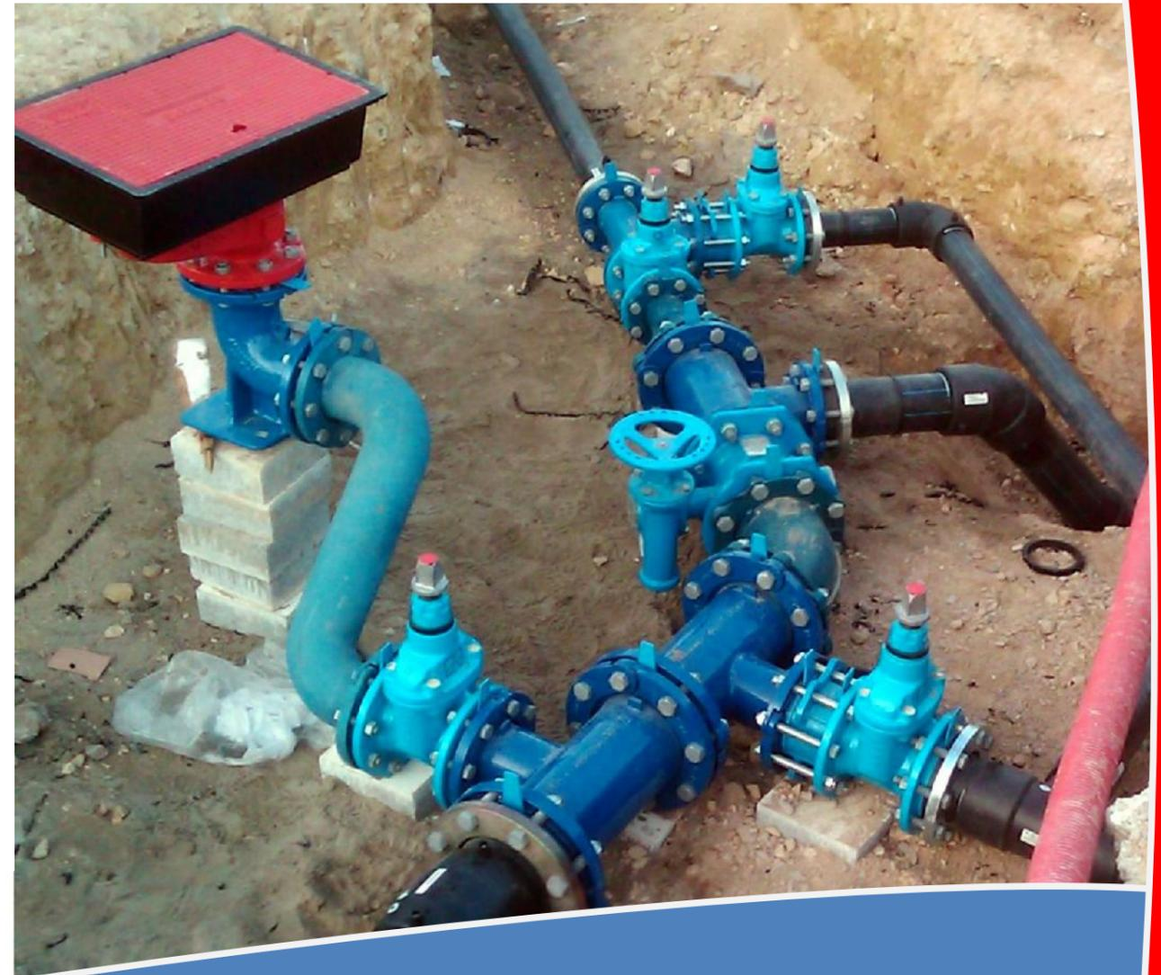
**REDES DE ABASTECIMIENTO:** tuberías de polietileno, fundición dúctil, PRFV, hormigón con camisa de chapa, de PVC, etc.
